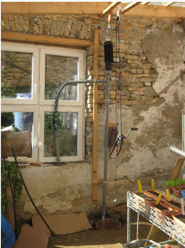
Die fertige Seilpumpe.
