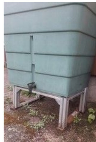
Rechtes Bild: Aufständigung für tonnenbasierten GWT mit Hahn
